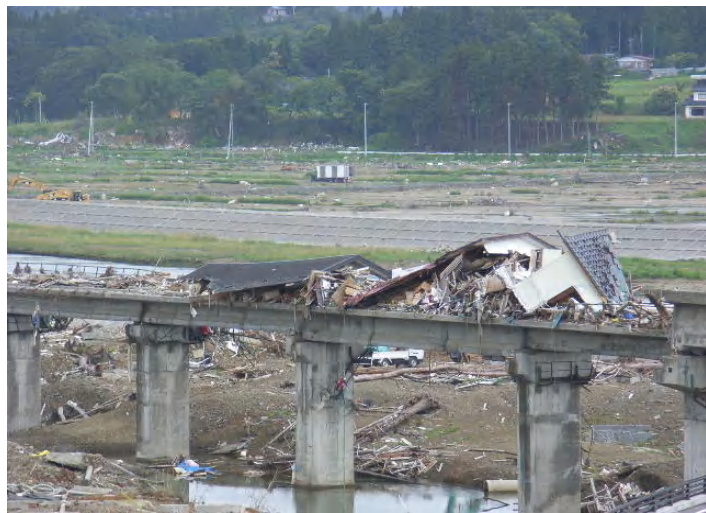
津波により気仙沼線の線路の上に乗った住宅2棟
